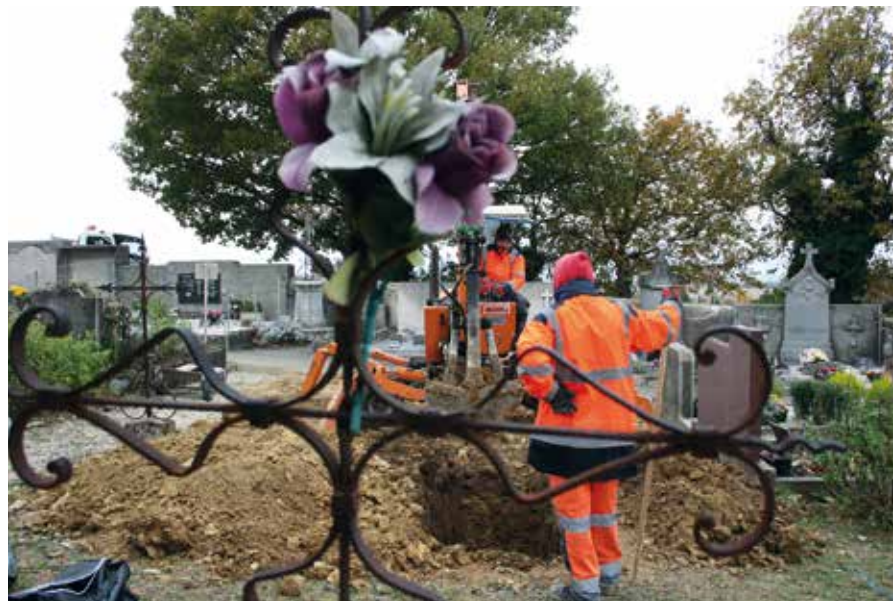
La mini pelle araignée avec laquelle l'équipe de l'entreprise agréée par l'état a réalisé les travaux.
